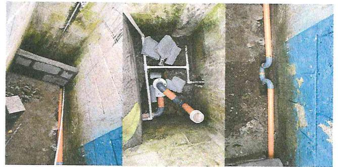
Foto 2: Área de los baños donde se hizo nueva instalación de tubería
