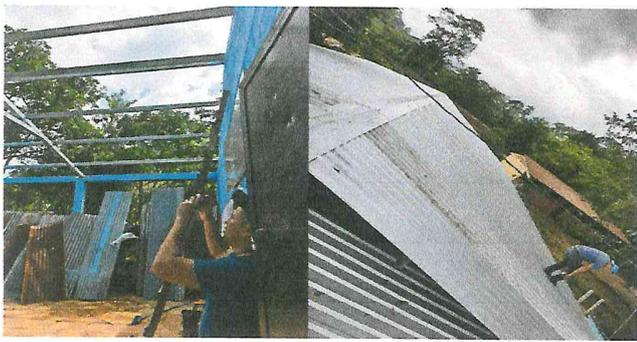
Foto 3: Instalación de costaneras nuevas y lamina troquelada
