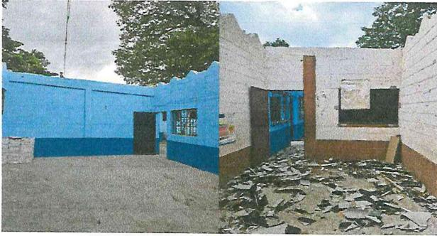
Foto1: Interior de las aulas, antes de colocar costaneras nuevas, duralita y lamina por lamina troquelada
