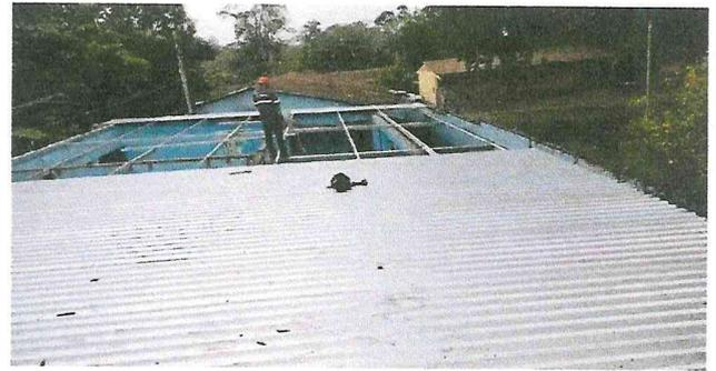
Foto 4: Instalación en dos aulas y dirección, de lamina troquelada y costaneras
